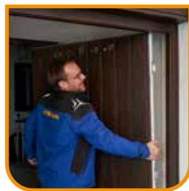
Demontaż i ekologiczna utylizacja
