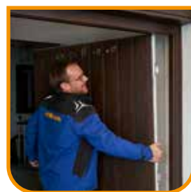
Demontaż i ekologiczna utylizacja
